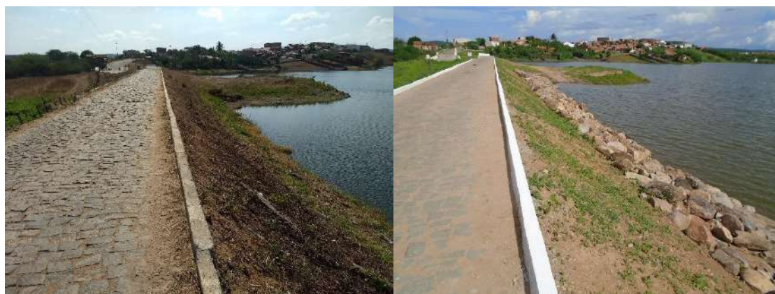
FIGURA 10.9. FOTOS ANTES E APÓS OBRA DE RECUPERAÇÃO NA BARRAGEM COLINA.
